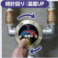
出口側の水温はミキシングバルブのレバーを左右に動かして温度計を見ながら調整を行います。
