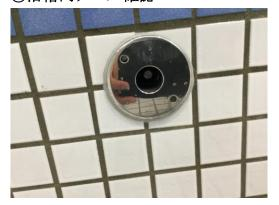
②専用工具でノズルを反時計方向に回す
