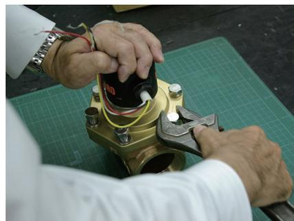
セット後再度給湯ユニットの試運転して開閉がスムーズに行われているか、弁からの漏れが無いかを確認して下さい。
